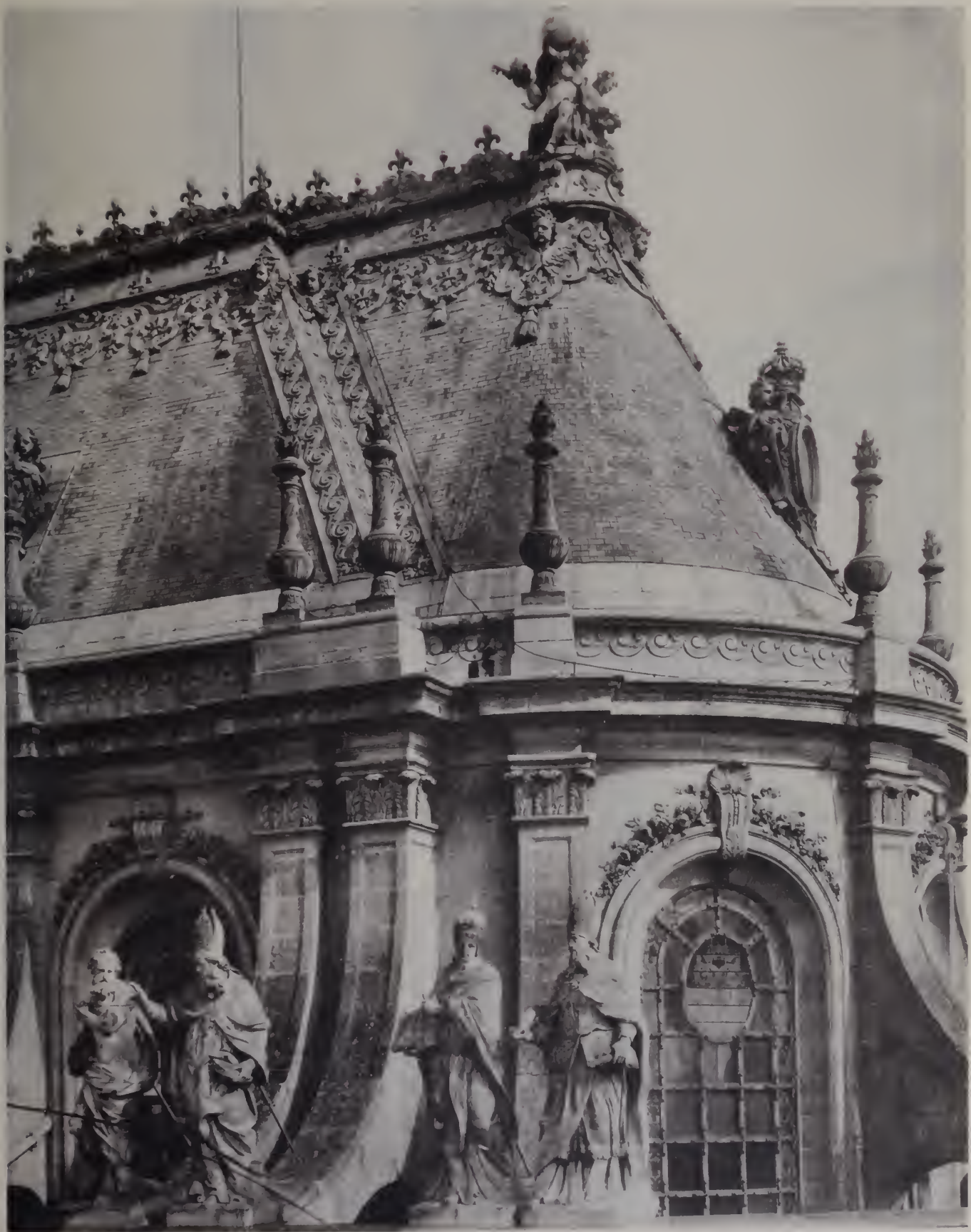
VERSAILLES DETAIL OF FACADE DE LA CHAPELLE
